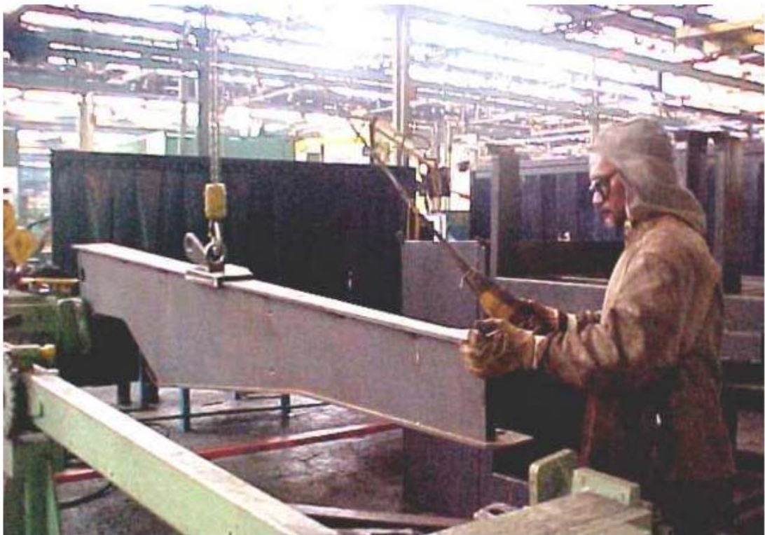
Foto 4: Retirada da peça já soldada para retoques finais. Movimento realizado com o uso de talha mecânica.
