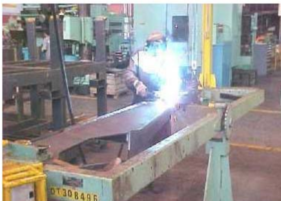
Foto 18: Solda longarina: Complementação das soldas em pontos intercalados.
